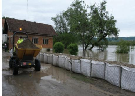
**Vodene pregrade** - metalni mobilni montažni protupoplavni sustav tipa vertikalni zid (u budućnosti bi trebao pružiti zaštitu od poplava u Hrvatskoj Kostajnici). Pregrade mogu biti i automatske te se podižu porastom vode.
